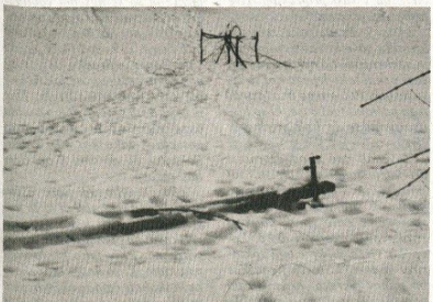
Ob izboljšanju vremena so kable in ostale napeljave izpeljali kar po zemlji in drevesih, samo da je elektrika v omrežju.
