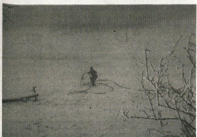
Elektrikarji so morali v težkih razmerah, od potrganih drogovih in pretrganih žicah, vse kable potegniti kar na roke.
